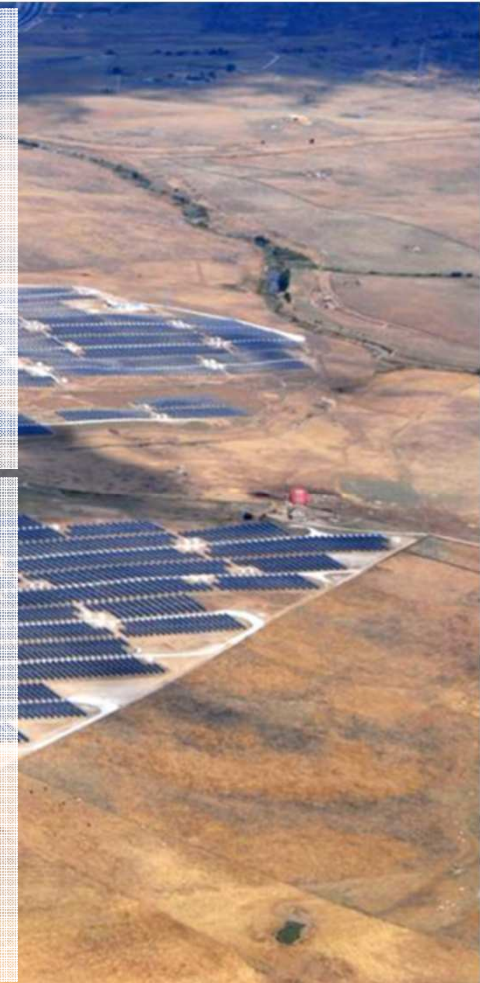
23 MW PV Plant, »La Magascona«, Trujillo, Cáceres (Spain)
